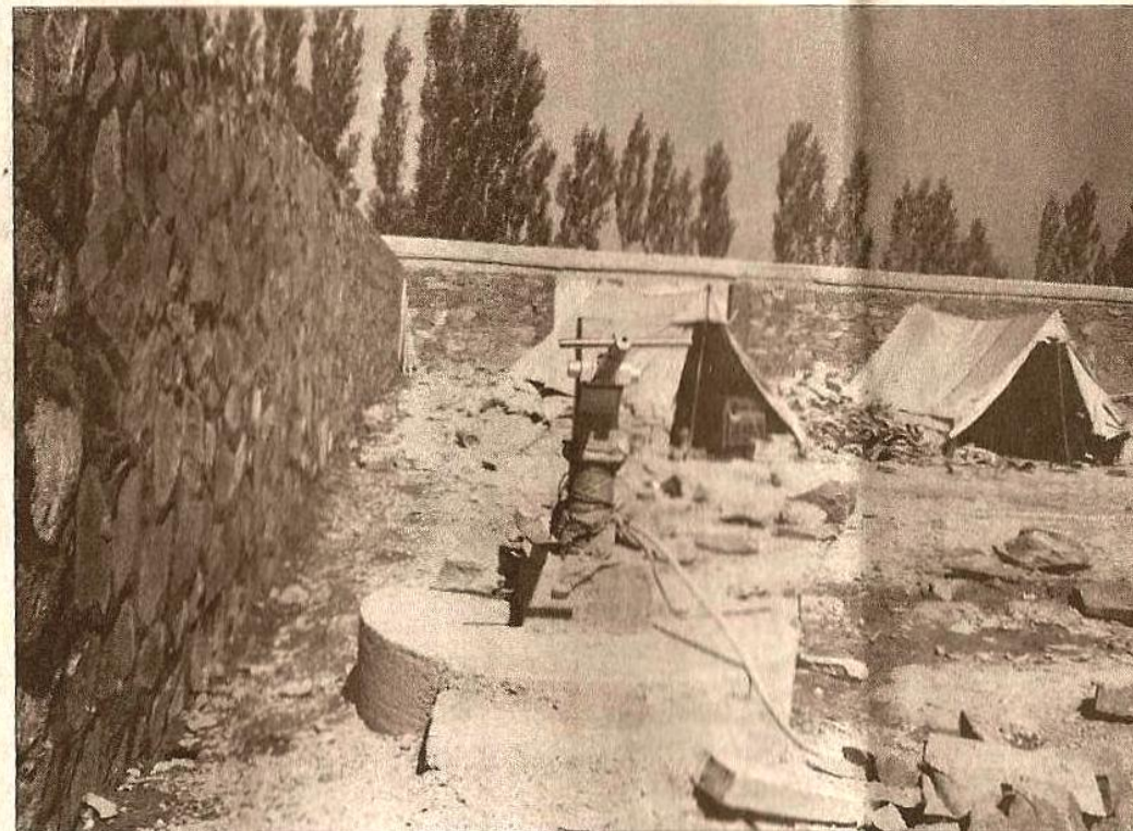
Aktueller Stand der Bauarbeiten in Daulatzai, Afghanistan: eine Mauer, ein Brunnen mit elektrischer Pumpe, ein Generator und zwei Zelte. Und kein Geld mehr. (i)
