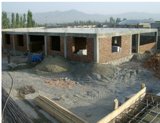
Abbildung 1: Der Rohbau des Ambulatoriums
